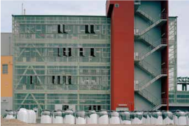
Licocene production building at Industriepark Höchst Produktionsgebäude der Licocene im Industriepark Höchst
